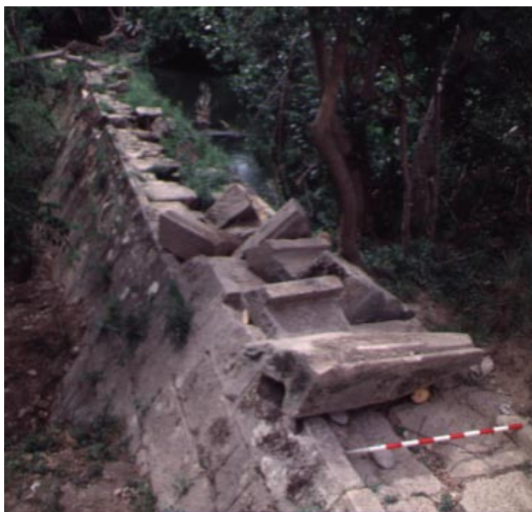
Presas que une las casas de noria
