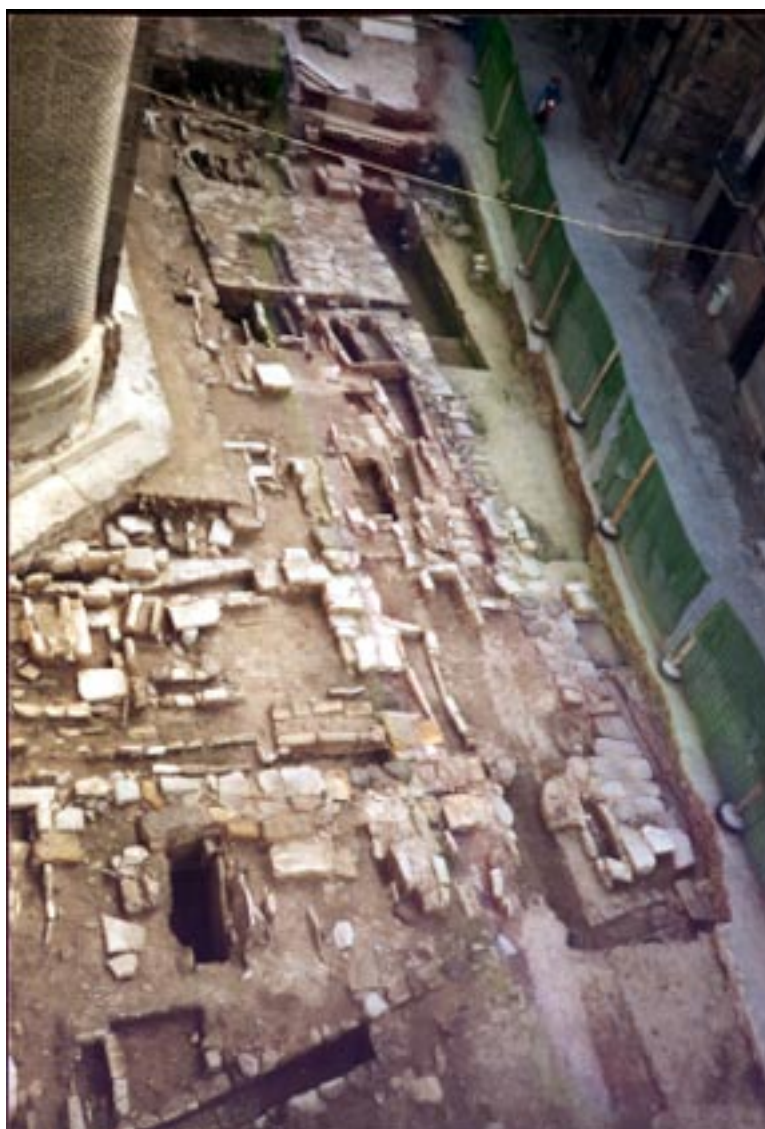
Foto 1. Vista general de la excavación.
