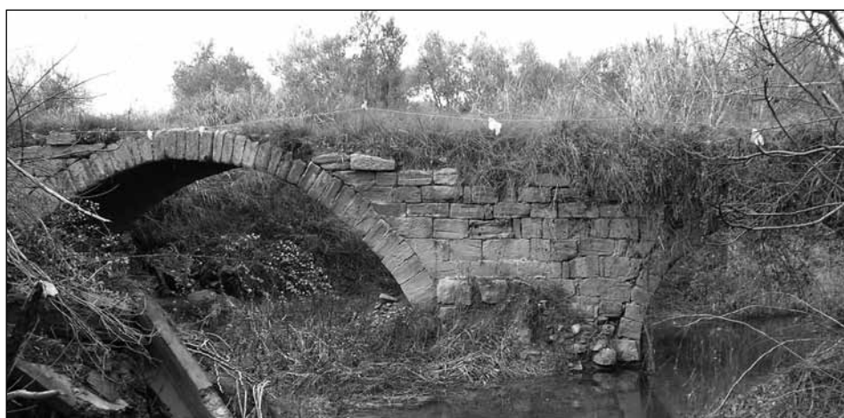
Figura 9. Puente del Palenque.
