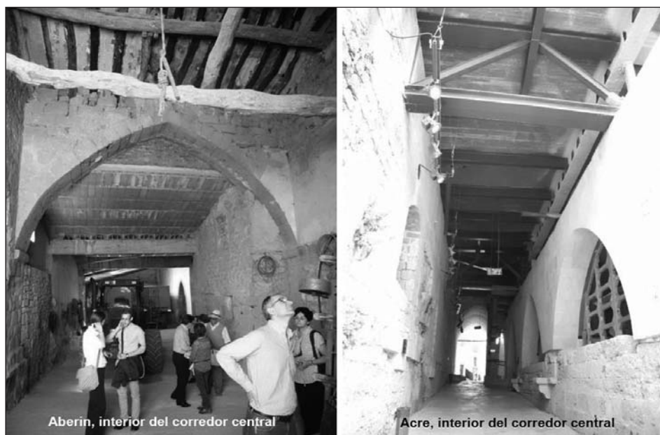
Figura 5. Interior de los corredores de Aberin y Acre. Vestigios conservados de arcos diafragma (Autor: J.Baldó).
