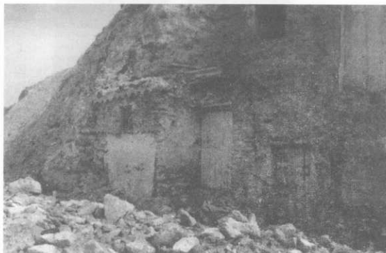
Foto nº 6: Detalle de la entrada y cuadra. Valtierra.
